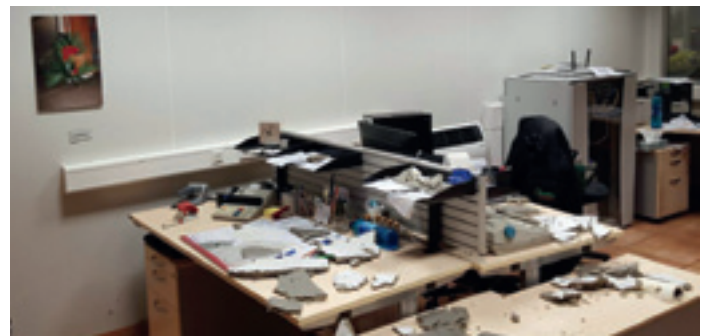
Im Kellerbereich von Fa. Köhler stürzte die durchnässte Decke ab.
