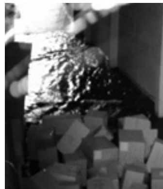
Wassermassen flossen über die Abfahrt in den BGM-Keller.
